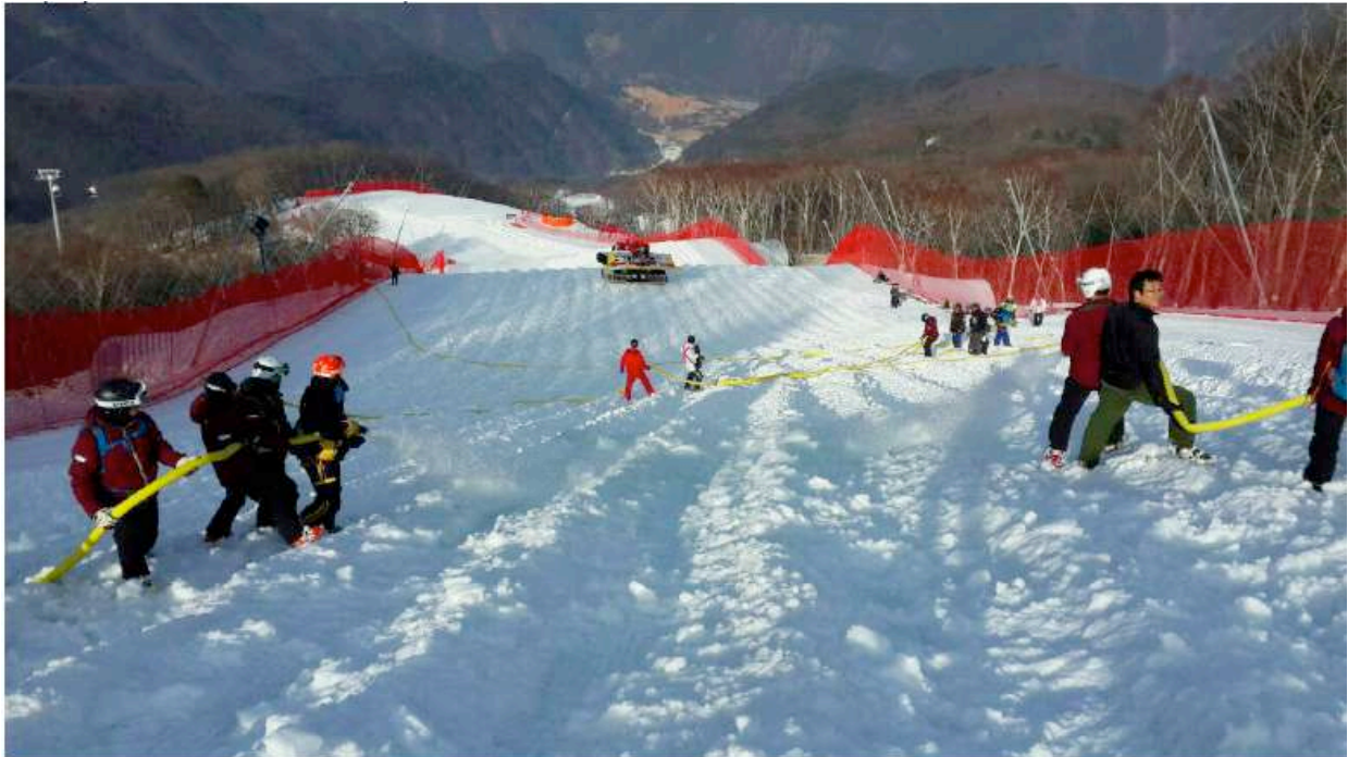
Заливка трассы водой
