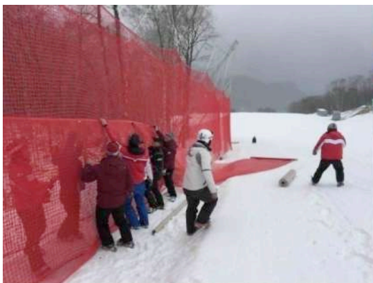
Установка юбки сетей А
