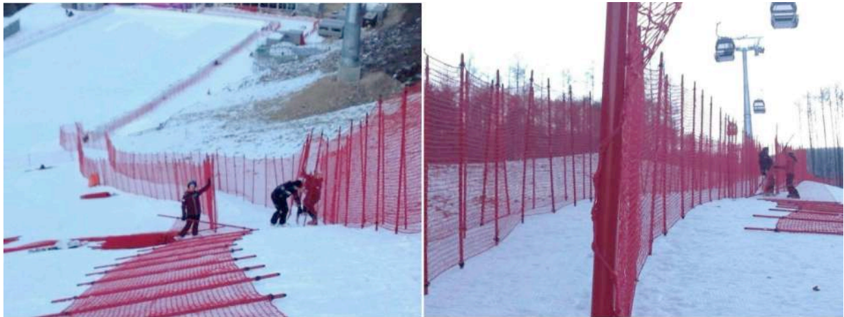
Пример установки сетей Б
